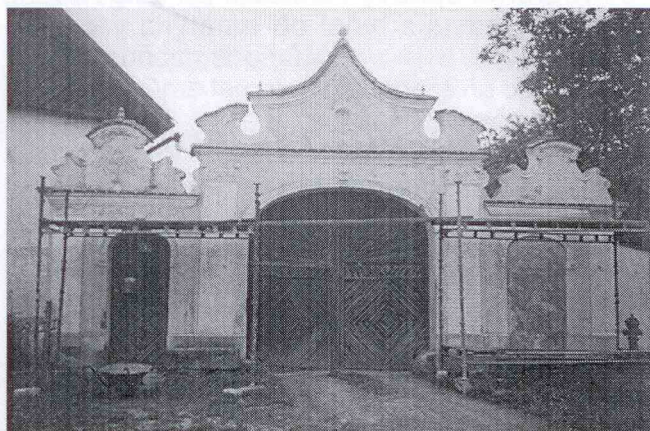
Oprava požární zbrojnice
